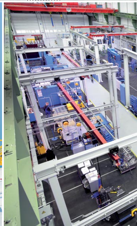
Spezialkrane / Special cranes
